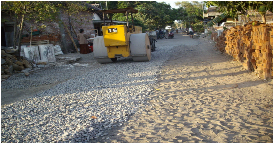
Foto 1. Pembuatan Jalan Desa Gemenggeng oleh Pakdhe Woto
